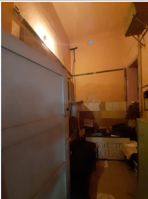
Rysunek nr 17 Skład opału w pomieszczeniu kotłowni (widoczna wentylacja grawitacyjna)
