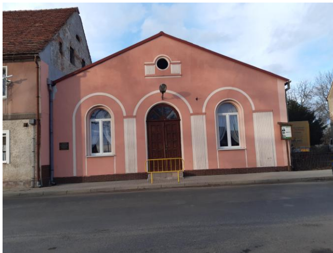
Rysunek nr 1 Budynek świetlicy wiejskiej w Niwicy
